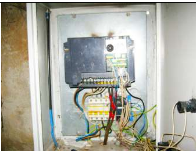
Рисунок 1.10 – ЧРП водозабора по ул. О.Кошевого
