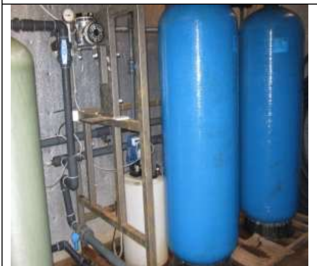
Рисунок 1.9 – Зал станции обезжелезивания водозабора по ул. О.Кошевого
