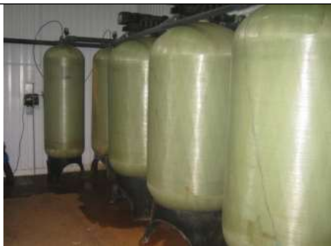
Рисунок 1.6 – Зал станции обезжелезивания центрального водозабора
